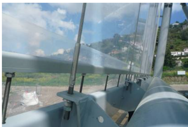
Figura 68 Immagine del prototipo – Dettaglio del fissaggio visto dall'interno. Fonte: International Journal of Structural and Construction Engineering, Nice Stadium: Design of a Flat Single Layer ETFE Roof , (ultima consultazione 11/09/2026)
