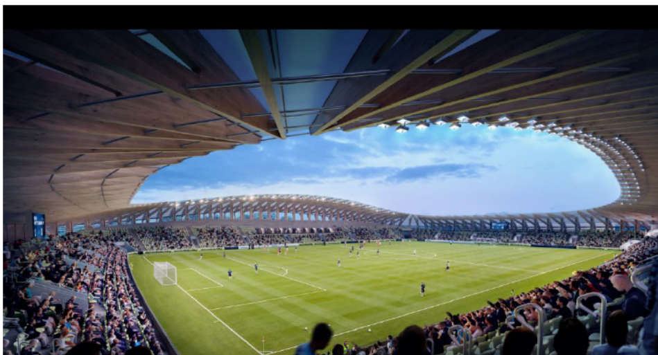
Figura 7 Dettaglio copertura. Fonte: Archdaily, Gli architetti Zaha Hadid inaugurano il primo stadio di calcio tutto in legno a Stroud, Regno Unito | ArchDaily (ultima consultazione 11/09/2026)
