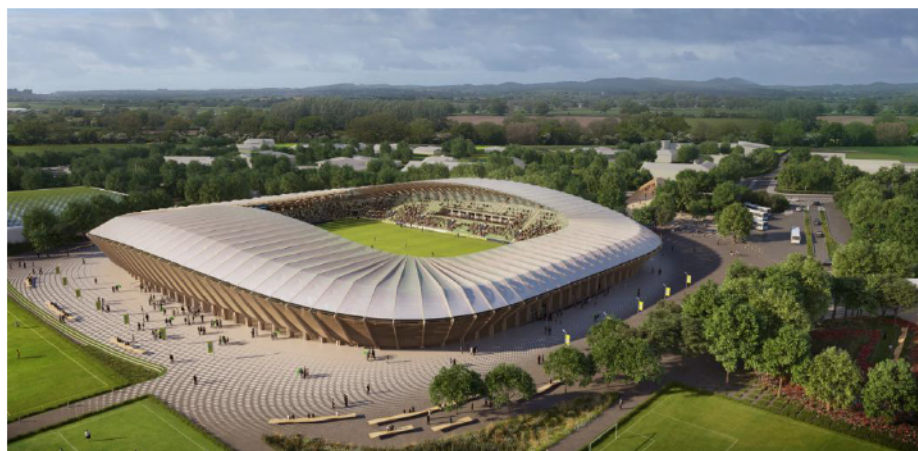
Figura 6: Scansione ritmica. Fonte: Archdaily, Gli architetti Zaha Hadid inaugurano il primo stadio di calcio tutto in legno a Stroud, Regno Unito | ArchDaily (ultima consultazione 11/09/2026)
