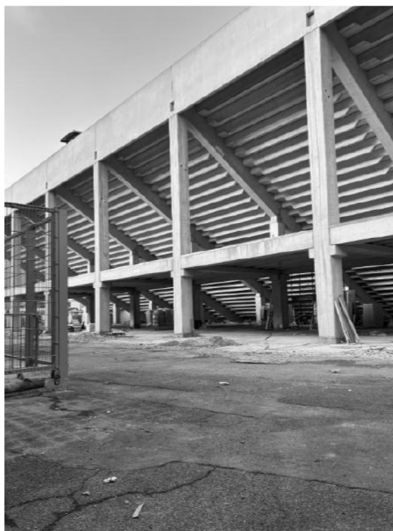
Figura 13: Intervento estate 2026, nuova tribuna Ovest. Fotografia personale
