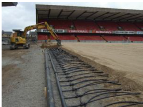
Figura 45 Installazione tubi di riscaldamento. Fonte: UEFA Pitch Quality Guidelines – 2025 Edition • Visualizzatore • Documents UEFA, fig.8, pag 13
