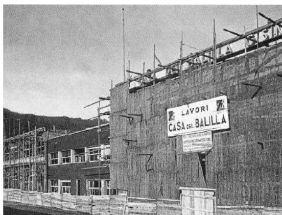
Figura 10: Lavori sulla facciata. Fonte: Old Como, Lo stadio Sinigaglia - Oldcomo (ultima consultazione: 24/08/2026)
