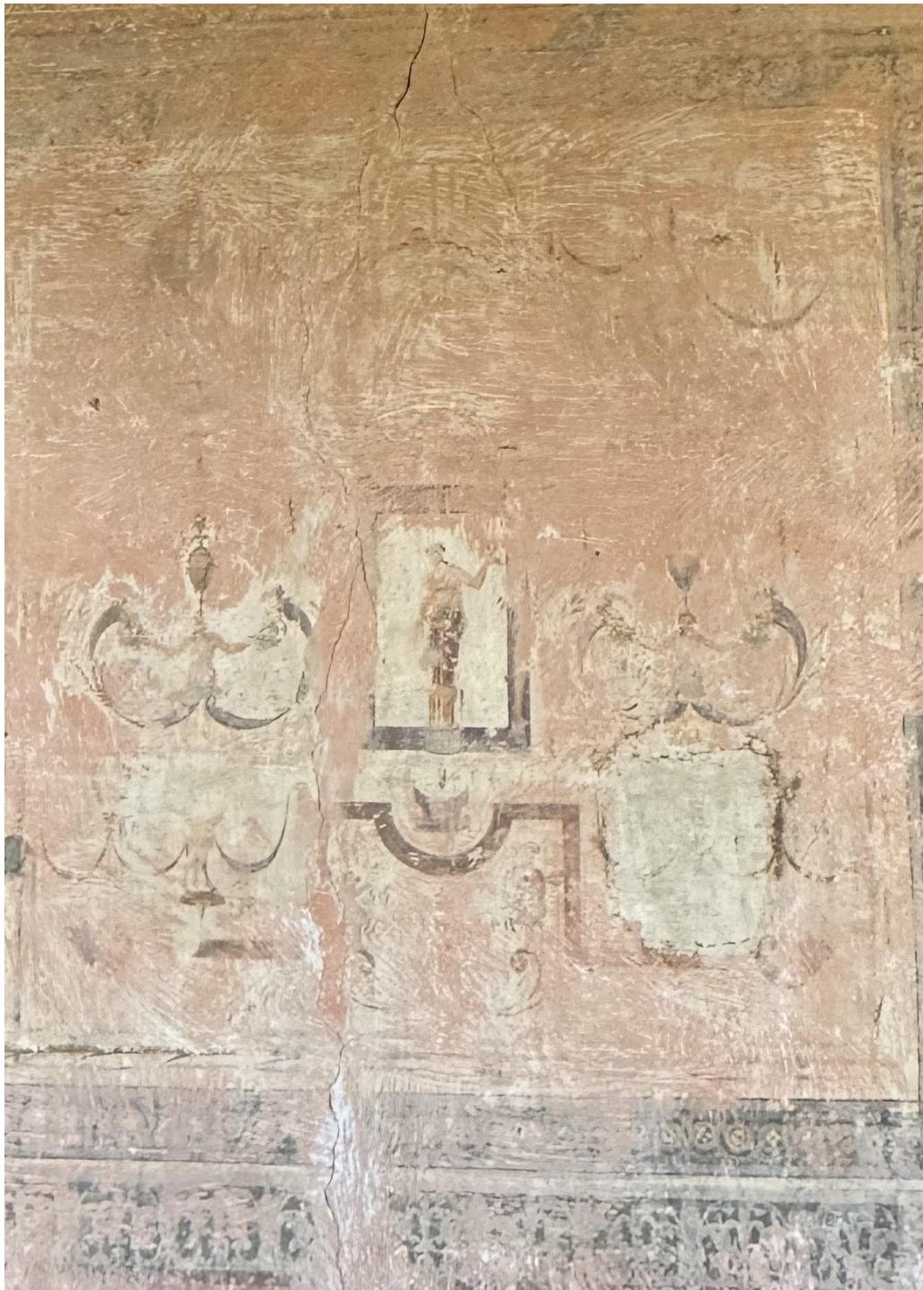
Figura 29: dettaglio della parete nord, Palazzo Oldofredi-Tadini Botti.
