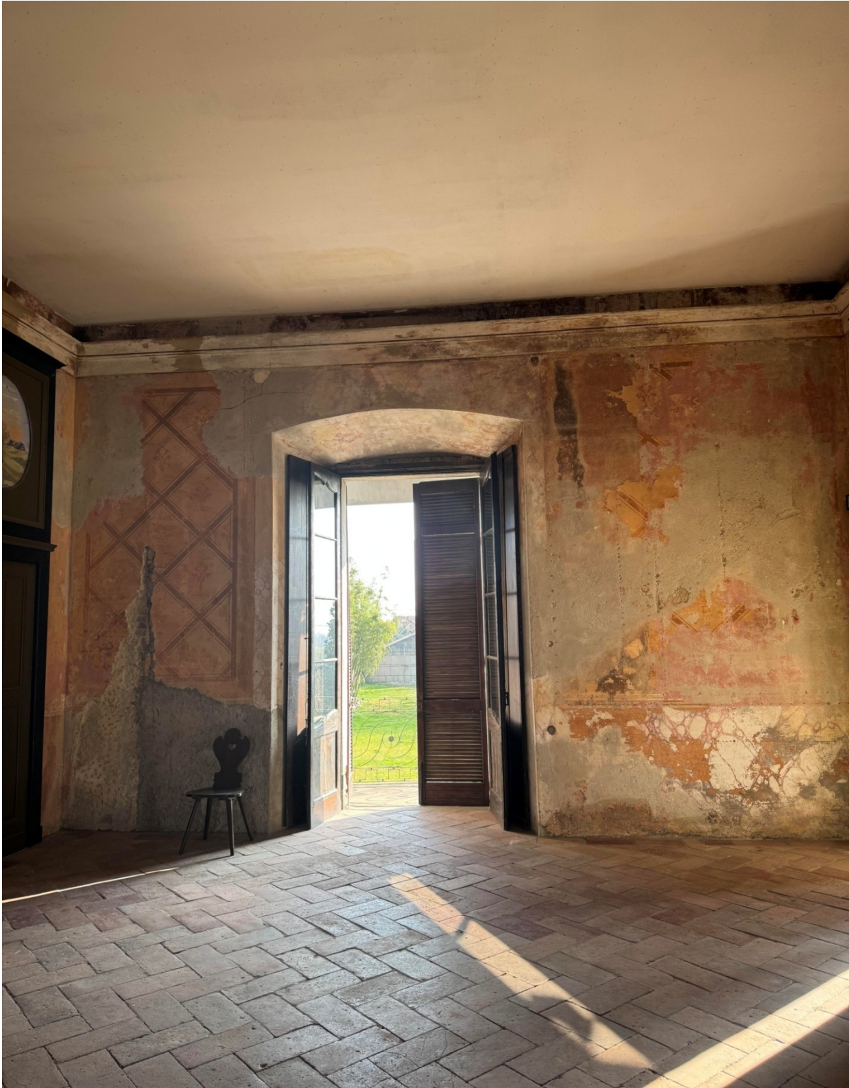
Figura 9: Veduta della prima stanza verso il lato sud, Palazzo Oldofredi-Tadini Botti.
