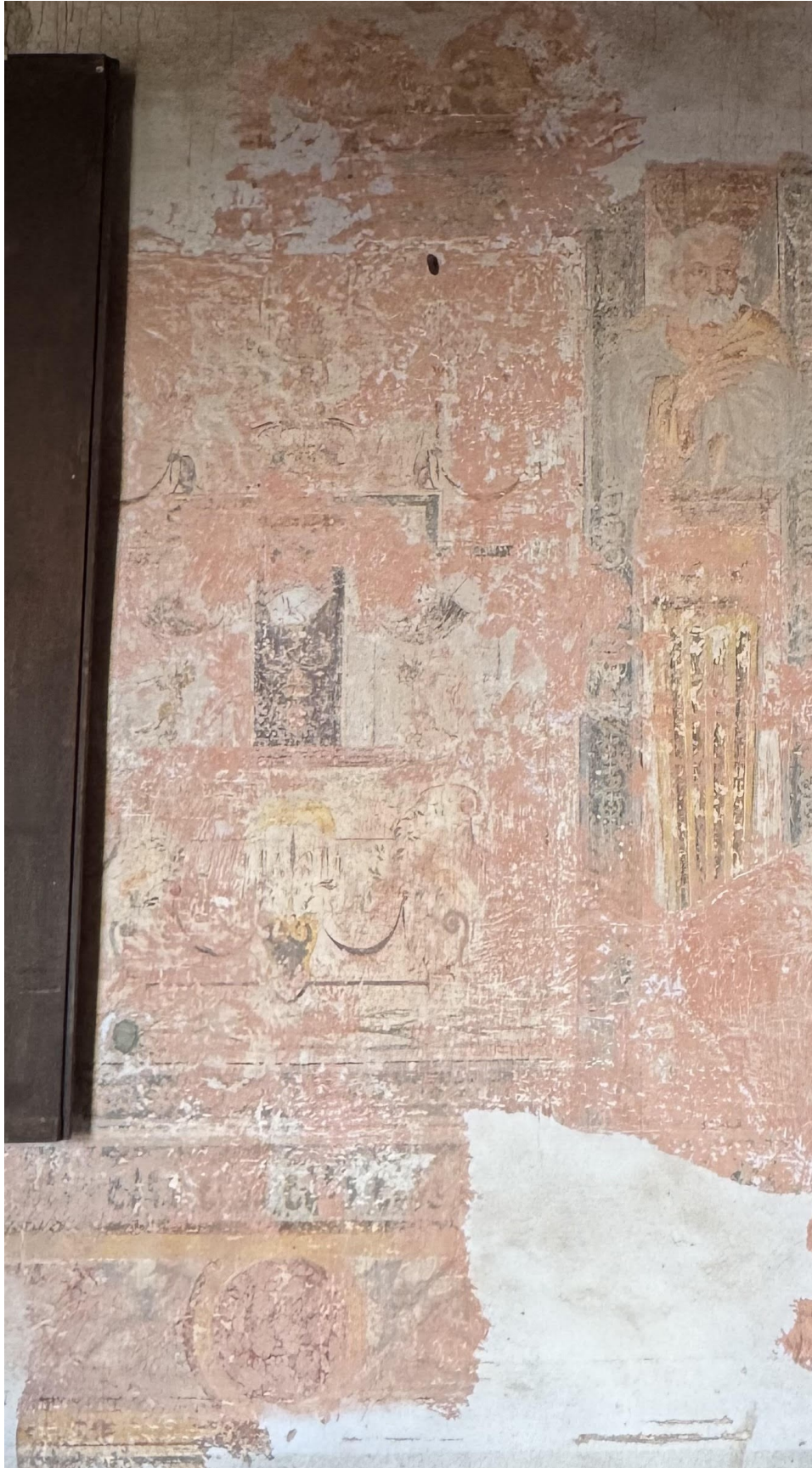
Figura 27: dettaglio della parete nord, Palazzo Oldofredi-Tadini Botti.
