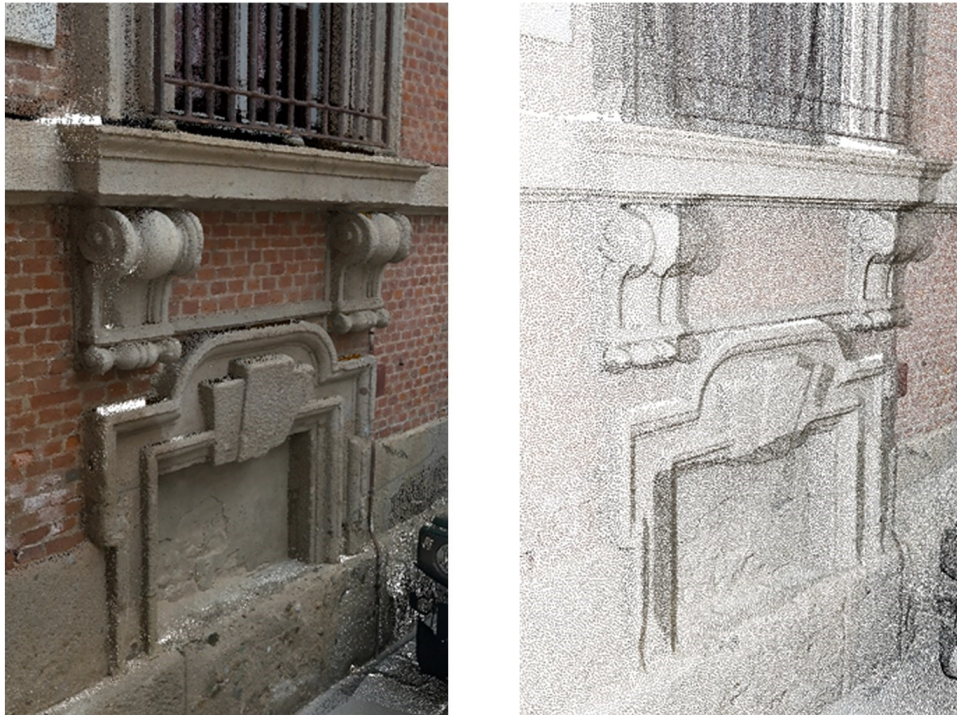
Figura 7.1. Effetto del sottocampionamento spaziale a 0,01 m su un dettaglio del fronte: a sinistra la nuvola grezza con il colore del rilievo, a destra la nuvola regolarizzata.
