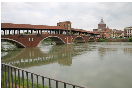
Figura 5.3: Ponte Coperto (lato valle) durante la piena del 2025
