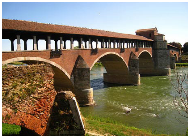
Figura 5.30: Ponte Coperto, lato monte
