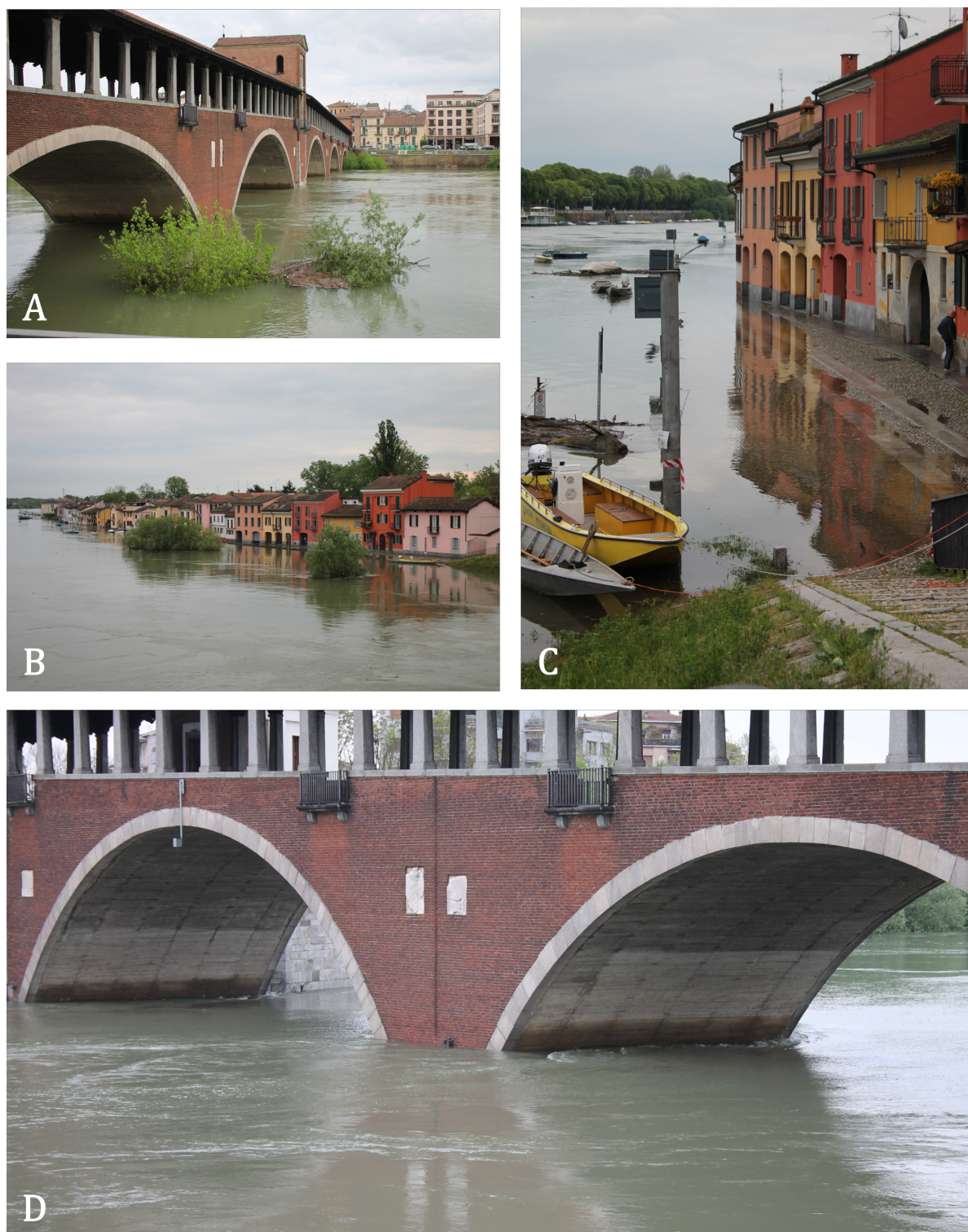
Figura 5.20: Piena del 2025 (19/04/2025; 7:30), documentazione fotografica: (A) Ponte Coperto lato valle (fotografato dal Borgo); (B) Borgo basso (fotografato dal Ponte Coperto); (C) Via Milazzo (fotografata dal Ponte Coperto); (D) Pila del Ponte Coperto sommersa
