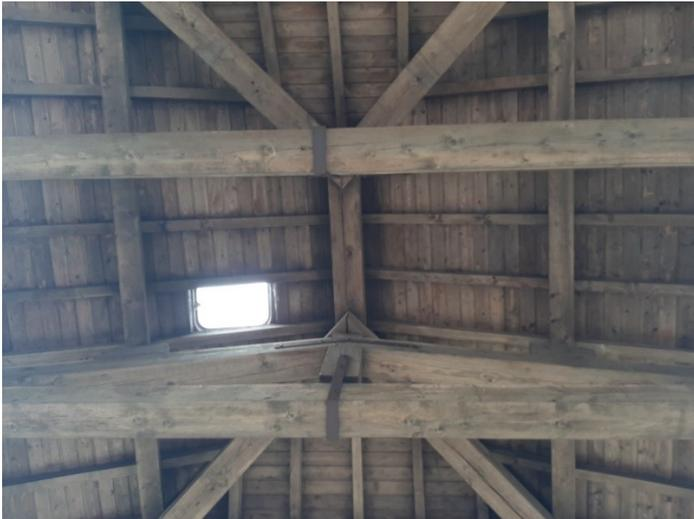
Figura 19-Travatura di sostegno del tetto.
