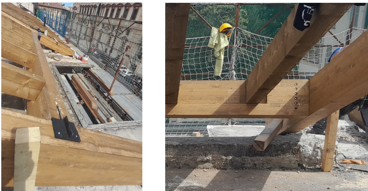
Figura 75: impiego di viti, piastre e basette d'acciaio a scomparsa per la connessione di due nuovi elementi in legno per la copertura del blocco E dell'Ex Ospedale Santa Margherita di Pavia (lavori di Studio Calvi BEAM BEAM).
