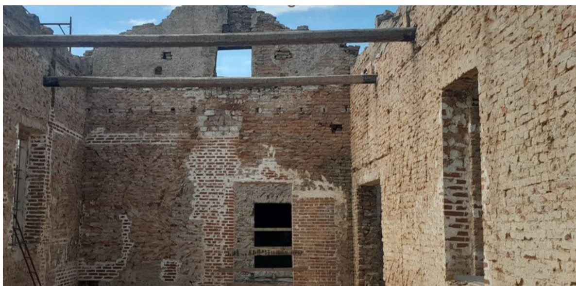
Figura 80: interventi di scuci e cucì di porzioni di muratura ammalorare durante il recupero dell'Ex Ospedale Santa Margherita di Pavia (lavori di Studio Calvi BEAM BEAM)
