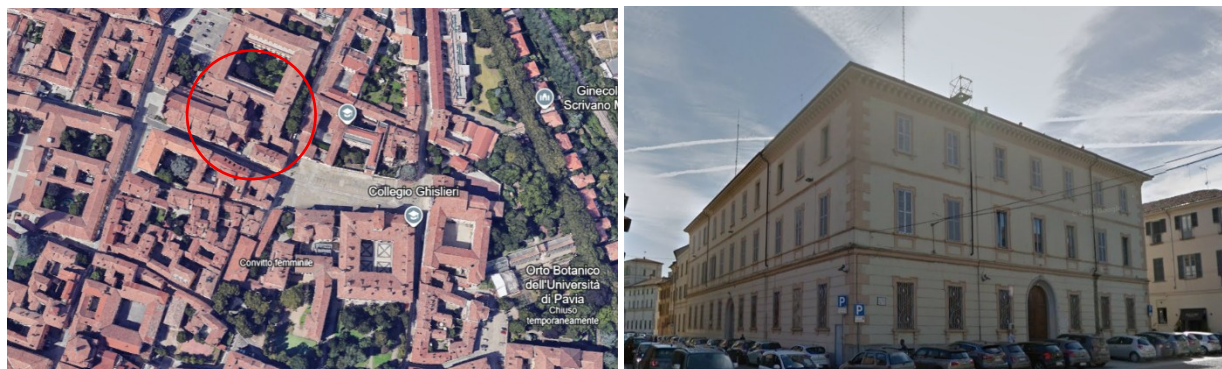
Figura 120: inquadramento dell'edificio nella città e vista della facciata principale
