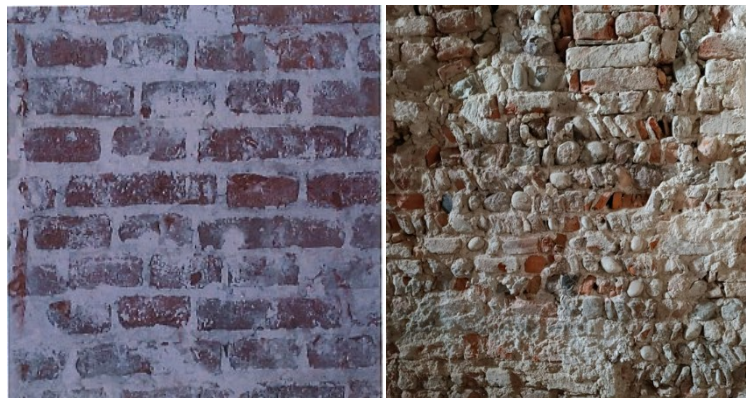
Figura 9: differenza tra l'aspetto di un paramento murario con elementi disposti in maniera ordinata e regolare (rinvenuto durante le indagini in sito per il recupero dell'Ex Istituto Mondino di Pavia, a sinistra) rispetto ad uno costituito da diversi materiali disposti in maniera caotica (rinvenuto durante i sopralluoghi per i lavori del recupero dell'Ex Ospedale Santa Margherita di Pavia)
