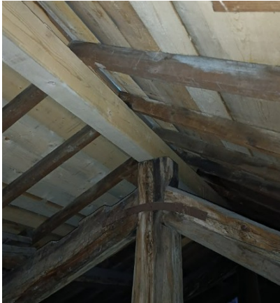
Figura 32: appoggio della testa di una capriata nella muratura del Palazzo San Felice a Pavia.
