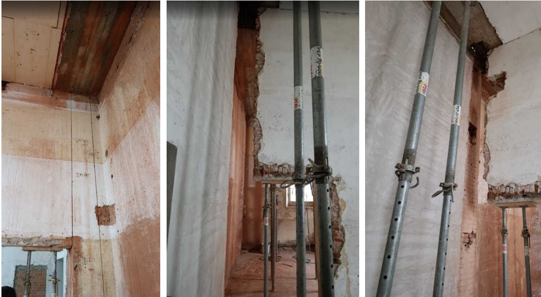
Figura 2: taglio verticale lungo l'altezza della muratura (a sinistra), breccia per l'inserimento dei montanti (al centro) e asole per la mensola saldata d'appoggio ai traversi (a destra).
