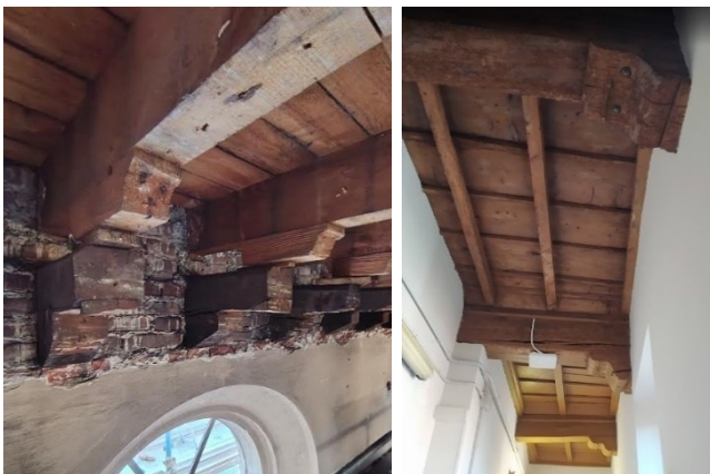
Figura 14: mensole a supporto delle travi in legno del solaio di sottotetto dell'aula magna dell'ex Istituto Mondino a Pavia (a sinistra) e del piano primo del Palazzo San Felice (a destra).
