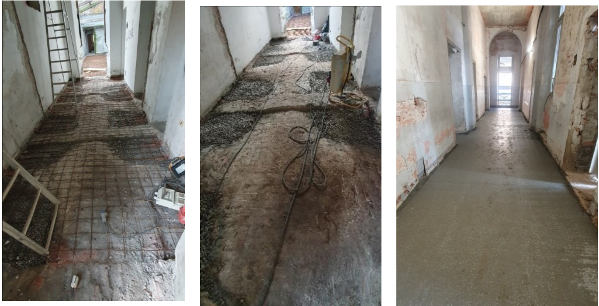
Figura 116: fasi del rinforzo delle volte con cappa collaborante in c.a. all'estradosso (lavori di Studio Calvi BEAM BEAM)
