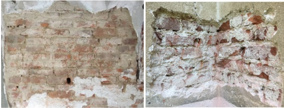
Figura 104: muratura in mattoni pieni correttamente ammassata osservata durante le indagini in sito (lavori di Studio Calvi BEAM BEAM)
