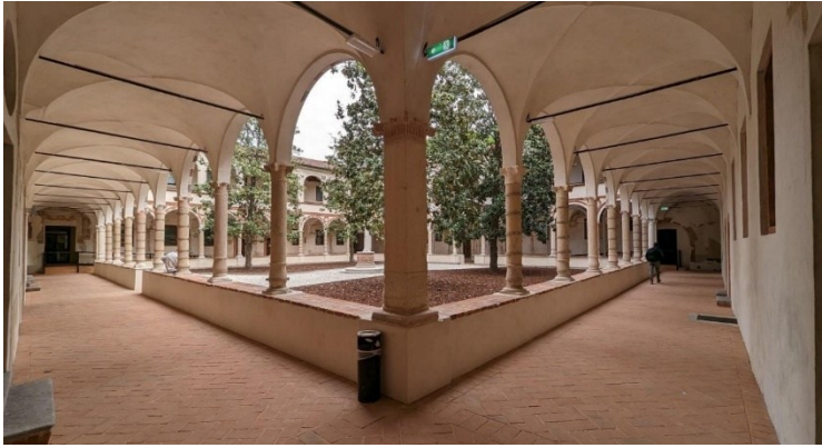
Figura 50: presenza di catene all'intradosso nelle volte a crociera del chiostro del Palazzo San Felice a Pavia.
