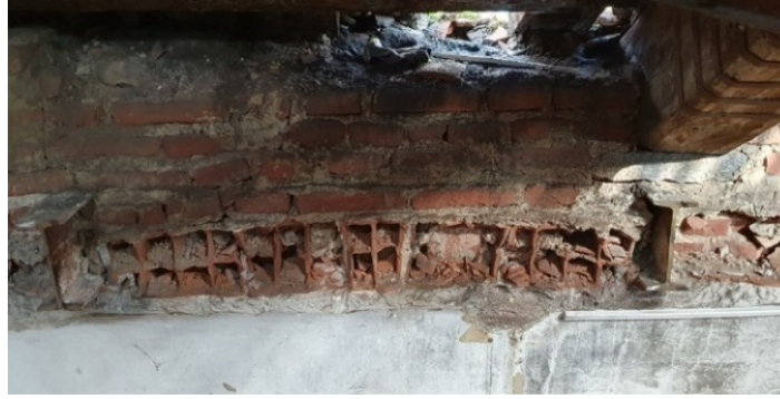
Figura 107: solai in putrelle e pignatte connesso alla muratura (lavori di Studio Calvi BEAM BEAM)
