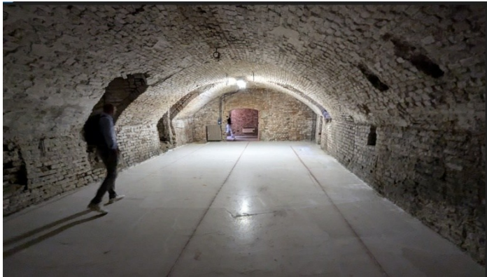
Figura 44: intradosso di una volta a botte ribassata in muratura del piano interrato del Palazzo San Felicea Pavia
