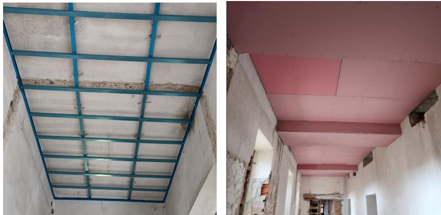
Figura 129: graticcio in acciaio per il supporto delle lastre REI con funzione anti-sfondellamento a sinistra) e loro posa in opera (a destra). Si nota la continuazione della struttura al di sotto delle travi in acciaio all'estradosso per ridurre la deformabilità del solaio).
