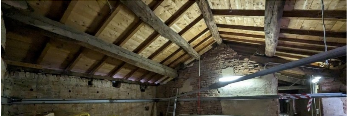
Figura 100: controventamento dei muri con cordolo in acciaio (lavori di Studio Calvi BEAM BEAM)
