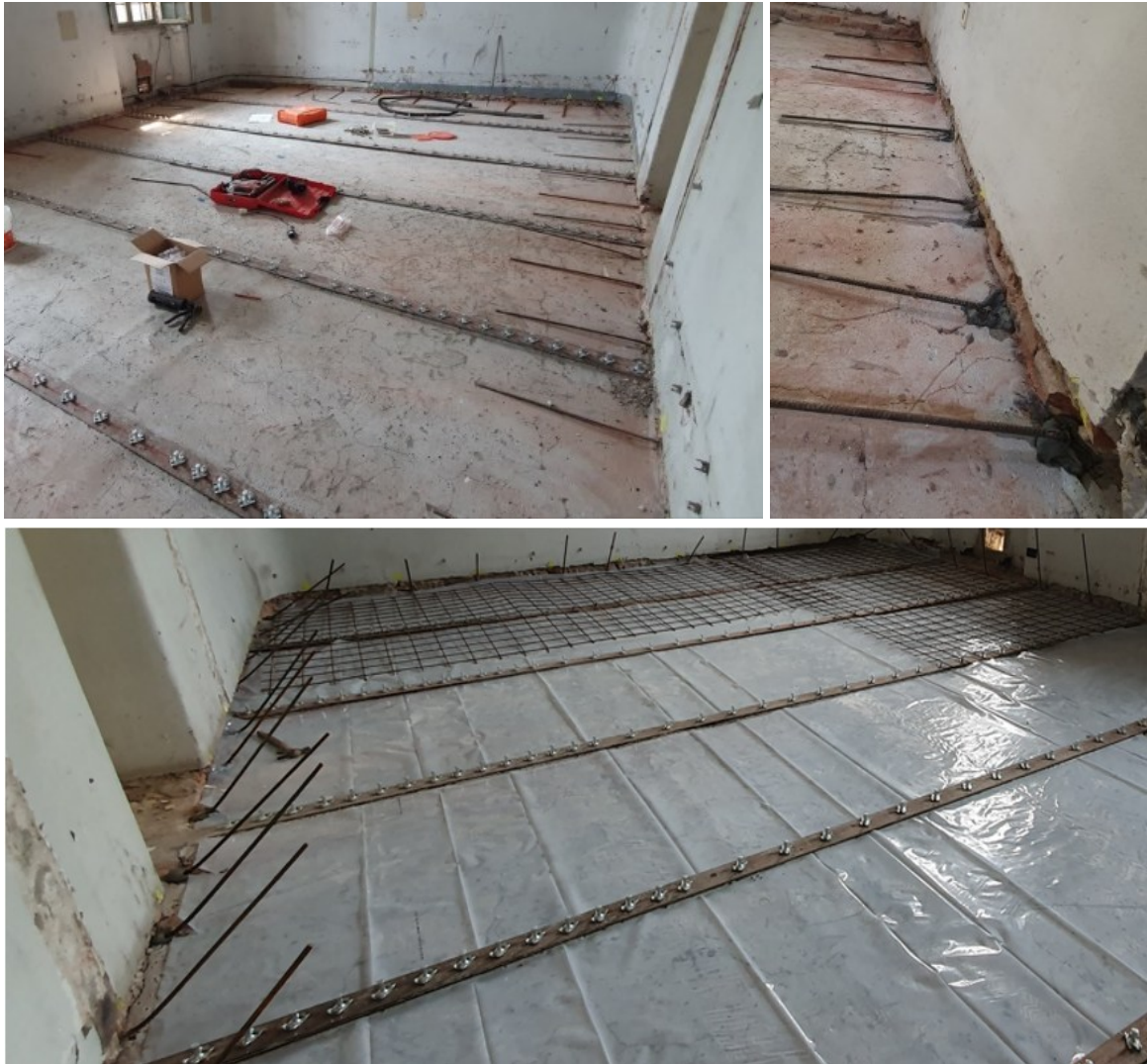
Figura 110: piolatura delle putrelle esistenti (in alto a sinistra), inghisaggio nella muratura delle barre d'ancoraggio della nuova cappa in c.a. alleggerito con foro saturato da resine bicomponenti (in alto a destra) e posa del telo impermeabile prima del getto (in basso). Lavori di Studio Calvi BEAM BEAM.
