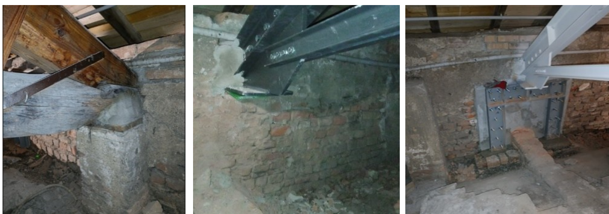
Figura 97: appoggio di una capriata esistente su pilastrini in muratura (a sinistra), appoggio provvisorio della capriata di progetto nella muratura perimetrale con piastra interposta (al centro), cavallotto in acciaio inghisato alla muratura per l'appoggio della capriata metallica (a destra). Lavori di Studio Calvi BEAM BEAM.
