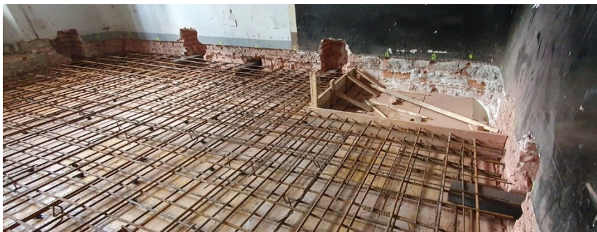
Figura 114: cassetta, armatura della soletta e inserimento di putrelle in scassi murari per il getto di un nuovo solaio a soletta piena in c.a. (lavori di Studio Calvi BEAM BEAM)
