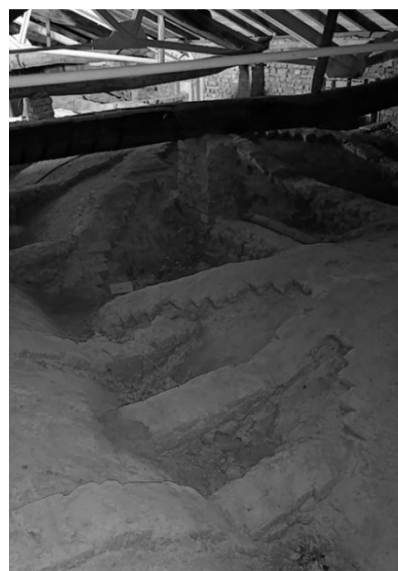
Figura 64: ritrovamento di frenelli in muratura per l'irrigidimento delle volte di sottotetto de Palazzo San Felice a Pavia visitato durante sopralluoghi
