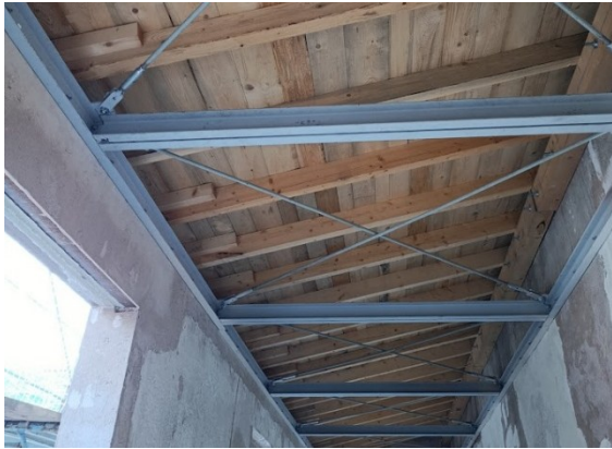
Figura 63: nuovo diaframma rigido in acciaio nell'Ex Istituto Mondino di Pavia (lavori di Studio Calvi BEAM BEAM)
