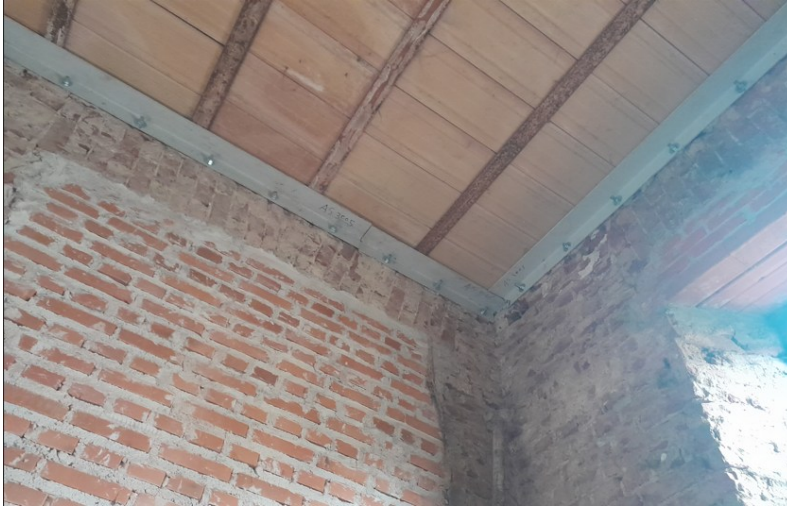
Figura 60: cordolo perimetrale in acciaio all'intradosso di un solaio in putrelle e tavelloni per il recupero dell'Ex Ospedale Santa Margherita di Pavia (lavori di Studio Calvi BEAM BEAM)
