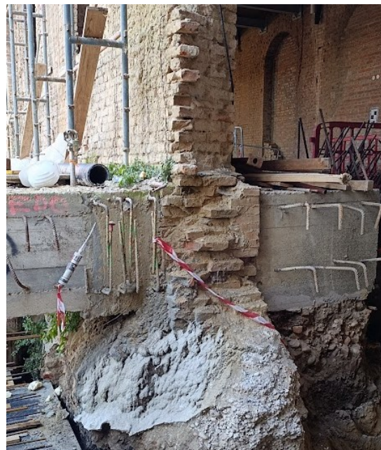
Figura 2: letto di ciottoli di dimensioni variabili rinvenuti dopo uno scavo per un cantiere su un vecchio edificio in muratura a Pavia. Presumibilmente vecchia fondazione di un edificio esistente in muratura del periodo romano.
