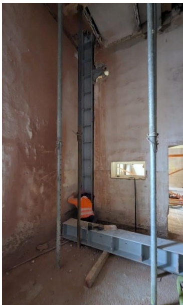
Figura 130: alloggiamento dei profili nel muro da demolire. Si nota la presenza della mensola saldata per l'appoggio e connessione del traverso (Lavori di Studio Calvi BEAM BEAM)
