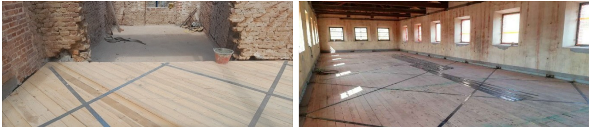
Figura 56: bandelle metalliche per l'irrigidimento nel piano di un nuovo solaio in legno per l'Ex Ospedale Santa Margherita di Pavia (a sinistra) e loro connessione al cordolo perimetrale nell'Ex monastero di Santa Monica a Cremona (a destra). Lavori di Studio Calvi BEAM BEAM
