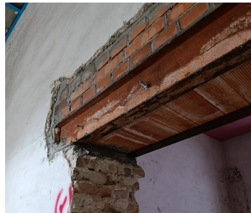
Figura 82: esecuzione di un architrave per l'apertura di una parete per il recupero dell'Ex Caserma Sacchi a Pavia (lavori di Studio Calvi BEAM BEAM)
