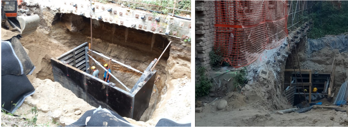
Figura 139: scavo e messa in sicurezza dell'area di lavoro contro il cedimento del terreno
