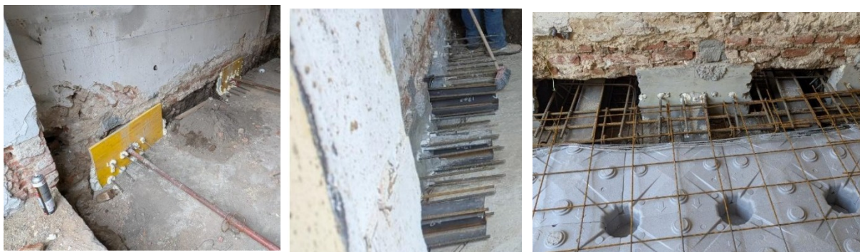
Figura 125: fasi della sottomurazione in calcestruzzo armato per il recuper della Ex Caserma Sacchi di Pavia (Lavori di Studio Calvi BEAM BEAM)
