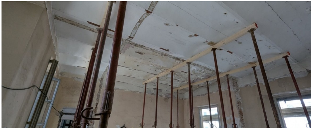
Figura 126: fasi di puntellamento dell'intradosso del solaio in putrelle e vittine (lavori di Studio Calvi BEAM BEAM)
