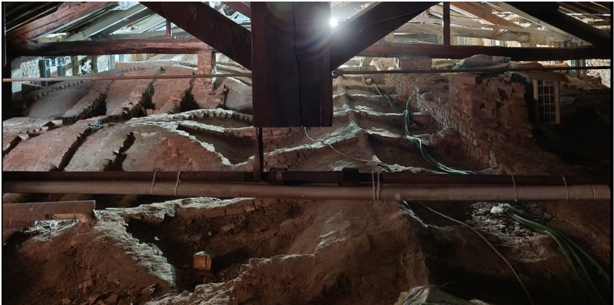
Figura 43: aspetto dell'intradosso di un sottotetto composto da volte e frenelli in muratura del Palazzo San Felice a Pavia visitato durante i sopralluoghi.
