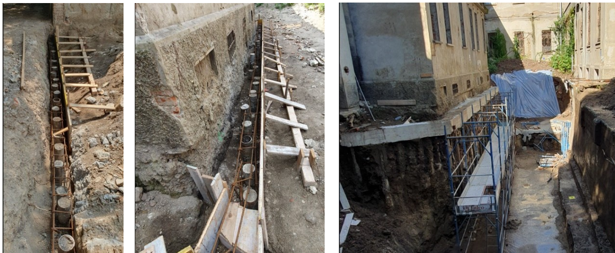
Figura 119: inserimento dei pali, armatura della trave testa palo e scavo per la realizzazione della vasca (lavori di Studio Calvi BEAM BEAM)
