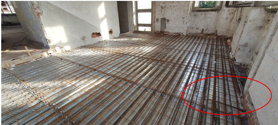
Figura 115: realizzazione di nuovi solai in lamiera grecata. Piolatura delle putrelle e fori per l'inghisaggio della cappa (lavori di Studio Calvi BEAM BEAM)
