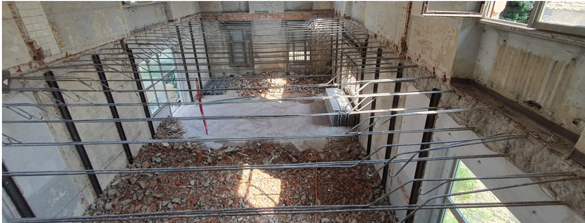
Figura 113: demolizione di un solaio STIMP: si nota la presenza di un cordolo perimetrale in c.a. e la presenza di barre lisce d'armatura
