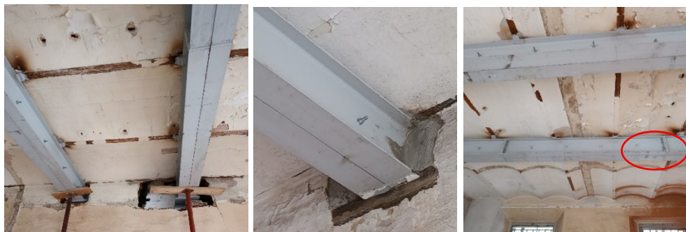
Figura 127: breccia nella muratura per consentire il passaggio nel solaio retrostante e appoggio provvisorio delle travi in acciaio, appoggio a fine realizzazione con malta a ritiro controllato e saldatura alle putrelle esistenti (in rosso). Si nota il collegamento su anime e flange tra i tronchi di travi
