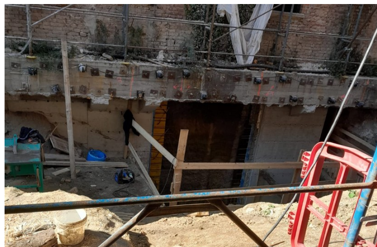
Figura 141: conci della nuova sottomurazione in c.a. (lavori di Studio Calvi BEAM)
