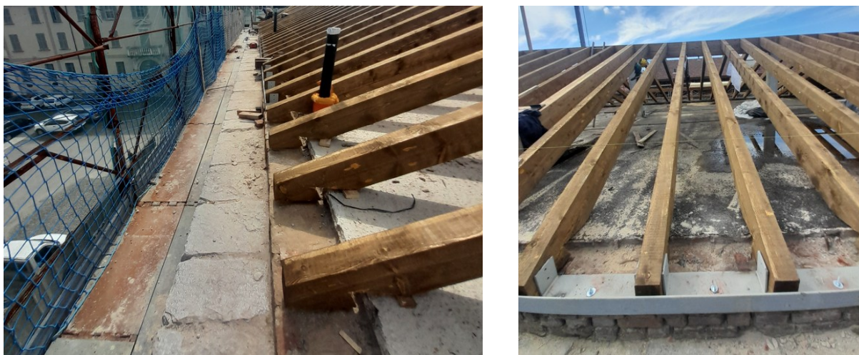
Figura 138: connessione delle nuove travi in legno alla muratura con profilo in acciaio (lavori di Studio Calvi BEAM)
