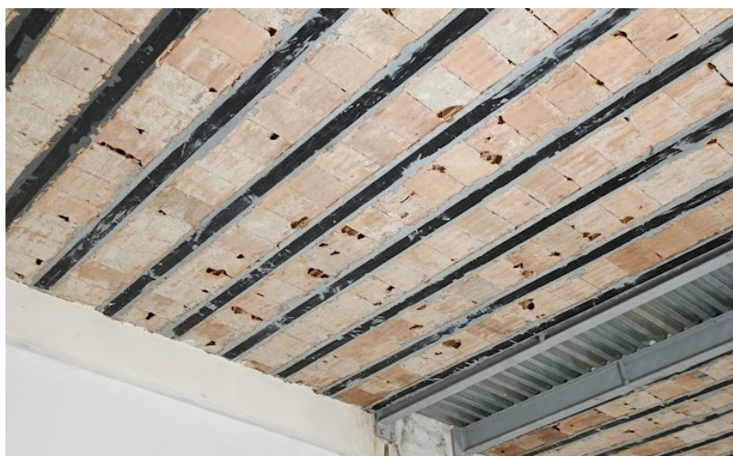
Figura 128: lamine di carbonio incollate all'intradosso dei travetti tralicciati per il rinforzo a flessione di un solaio in laterocemento (Lavori di Studio Calvi BEAM BEAM)
