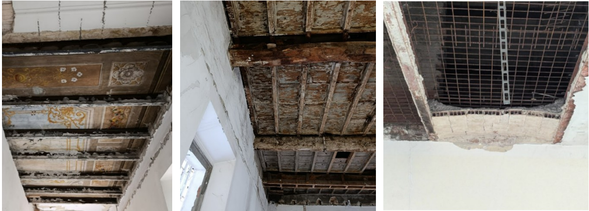
Figura 122: solai rinvenuti durante i sopralluoghi. A sinistra un solaio in putrelle e laterizi decorato, al centro un solaio storico in legno con travetti poggiati sulle catene, a destra solaio in putrelle e laterizio da demolire per eccessiva fragilità
