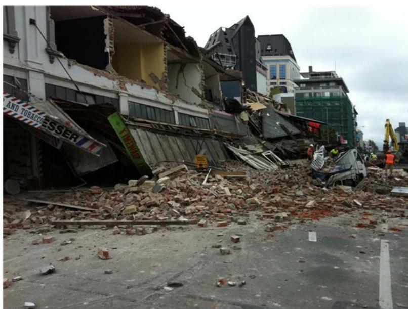
Figura 1.1: Collasso di pareti murarie a seguito del terremoto di Christchurch (Nuova Zelanda, 22 febbraio 2011, Mw 6,2).
