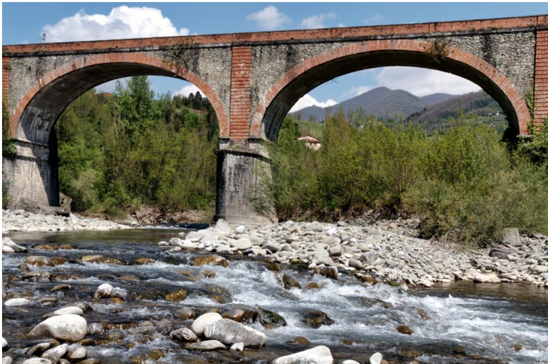
Figura 11: Ponte di Campia sul Serchio.
