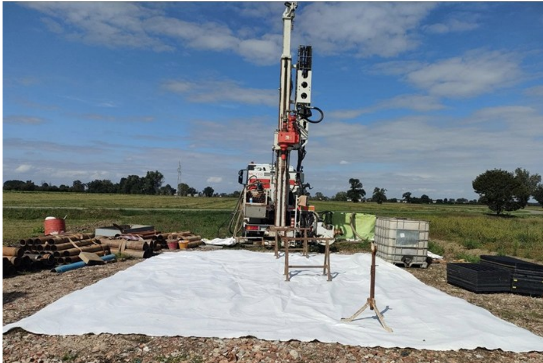
Figura 3.2: Foto perforatrice idraulica Comacchio modello MC-T10 con l'intero cantiere del sondaggio.
