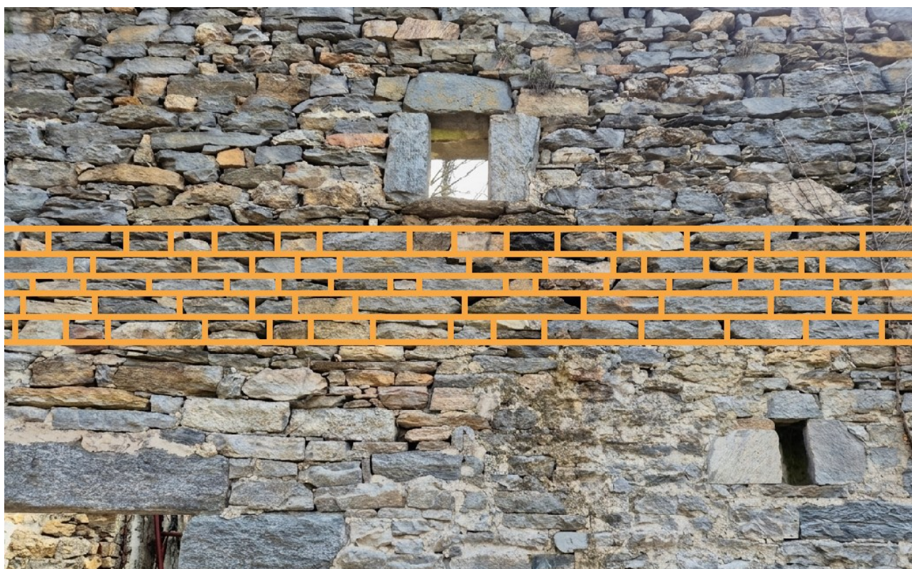
Figura 4.1 Rappresentazione del processo di definizione della tessitura muraria
