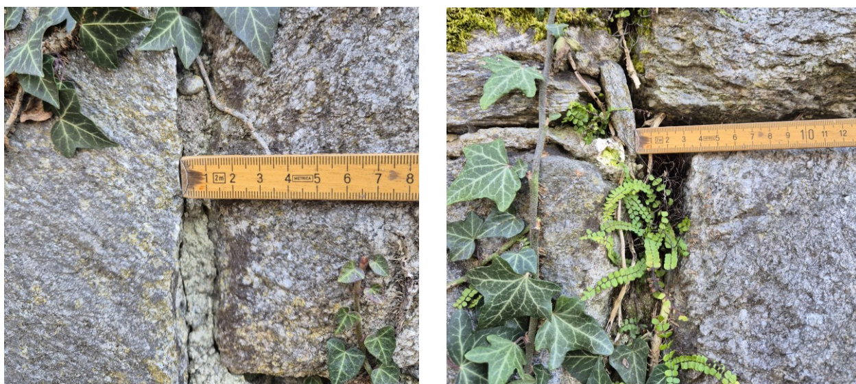
Figura 8.17 Particolare dello spessore del giunto
