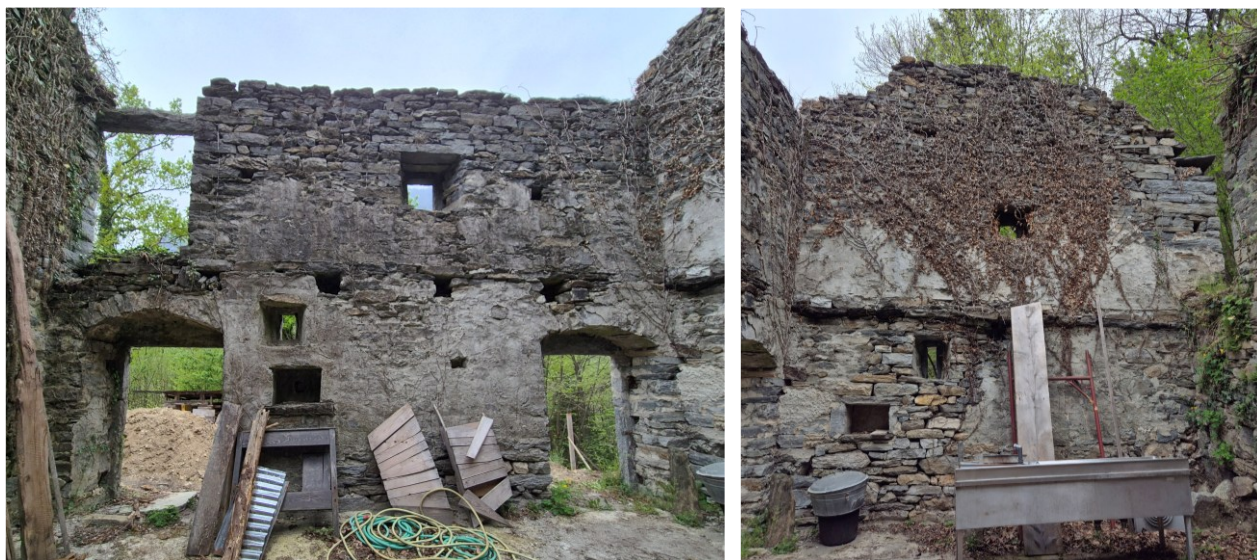
Figura 2.6 Viste dei fronti interni Ovest (sinistra) e Nord (destra) dell'edificio, con evidenza delle aperture originarie
