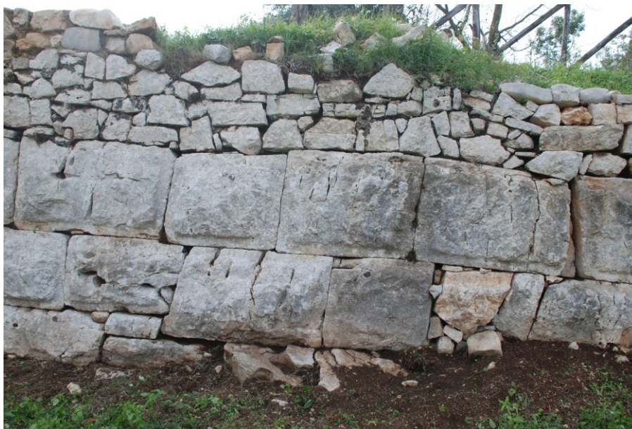
Fig. 1- Muro in poligonale. Immagine concessa da insegnamento di Archeologia dell'Italia preromana, Unipv.
