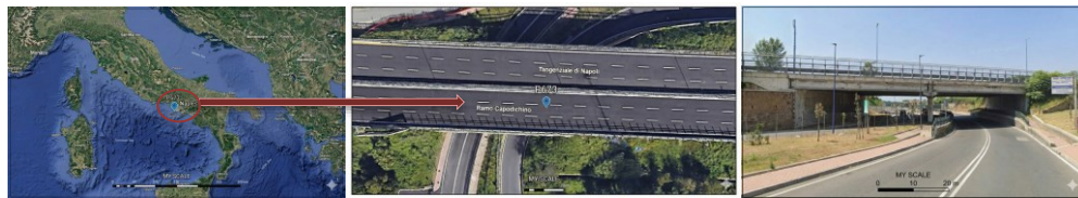
Figure 3-1 Case study bridge P673 on the Tangenziale di Napoli (A56) crossing over Via Fascione
