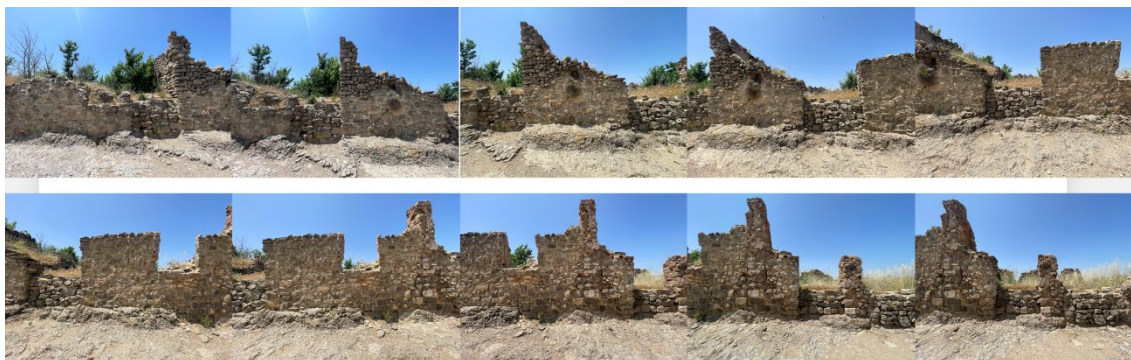
Figura 13: Rilievo fotografico in sequenza della cortina muraria in pietra che delimita il lotto oggetto di studio (realizzazione a cura del Politecnico di Valencia)
