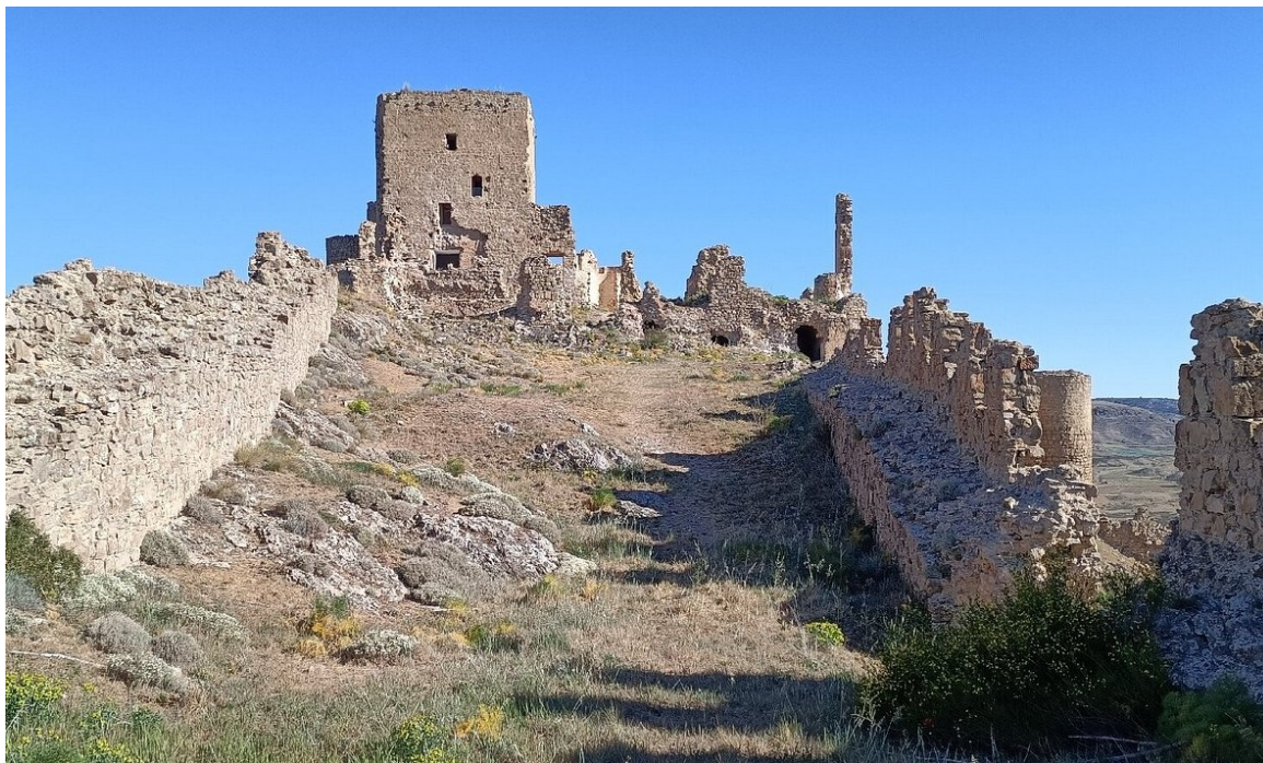
Figura 10: Percorso di accesso alla cortina muraria sommitale di Moya con i resti del corpo principale del castello
